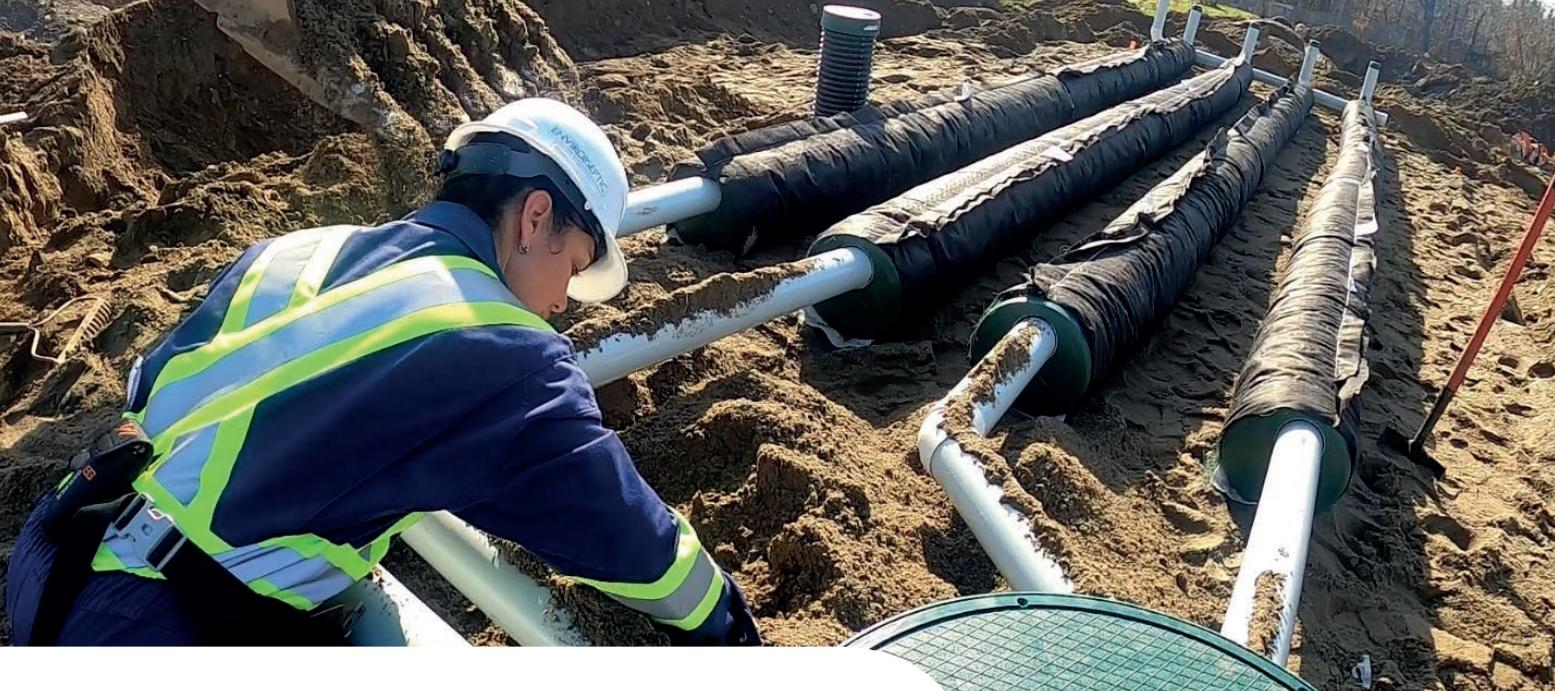
La répartition des eaux est un élément primordial au fonctionnement optimal et durable d'un système septique utilisant une superficie précise. Que ce soit une technologie conventionnelle tel tranchée d'infiltration, lit d'infiltration, élément épurateur ou champ de polissage, plusieurs options de distribution des eaux sont disponibles.
